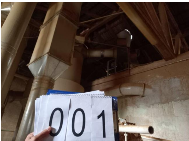
001-Sustav otprašivanja peletirke i sustav za otpadnu vlažnu prašinu
